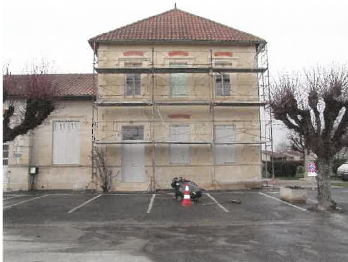
Rénovation de la façade de la mairie
