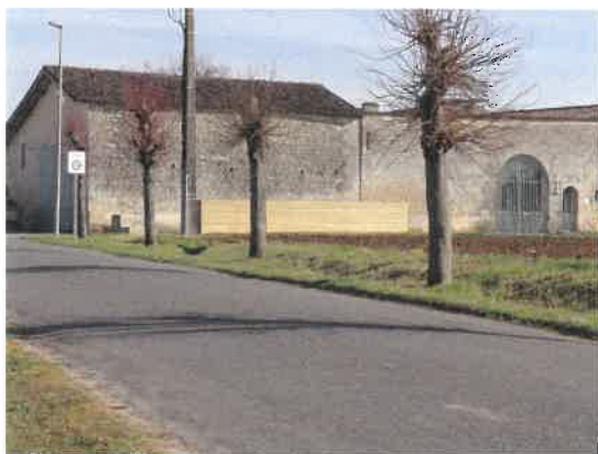
Bardage bois pour les bacs à ordures ménagères
