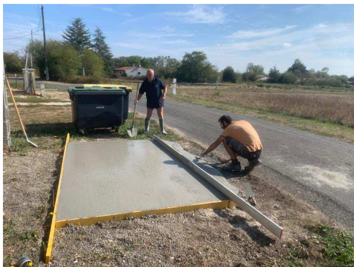
Rénovation des plateformes de collecte des ordures ménagères par les employés communaux, pour répondre aux normes demandées par l'entreprise de collecte.
