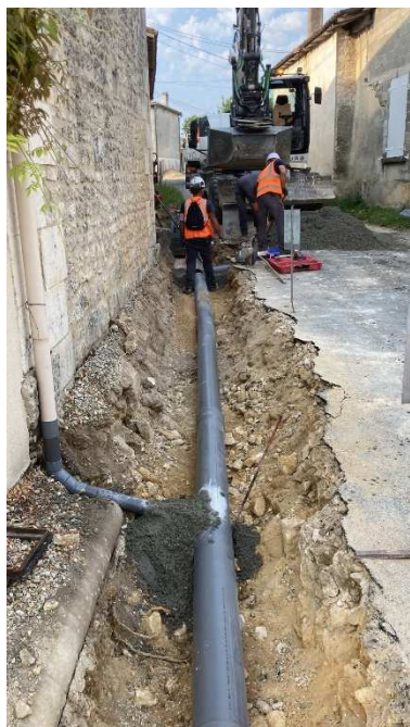
Rénovation réseau d'eaux pluviales de Lansac
