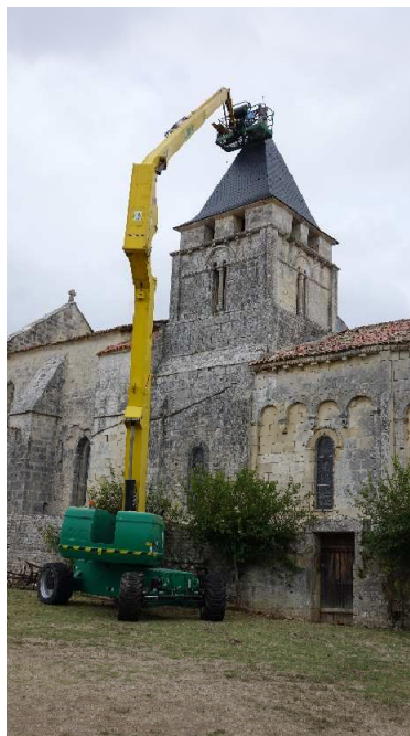
Réparation du toit du clocher suite aux dégâts de tempête du 20 juin.
