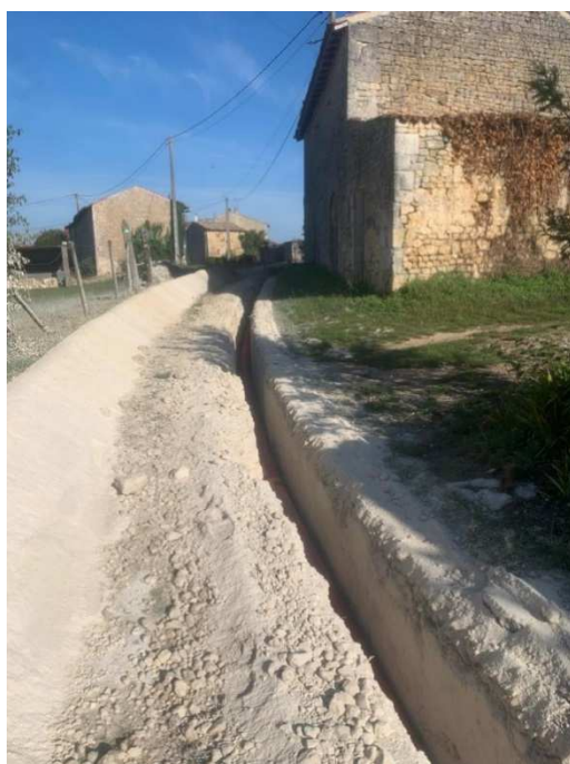
Village de St Paul : Travaux d'enfouissement du réseau par Enedis suite au sinistre de tempête sur le transformateur.
