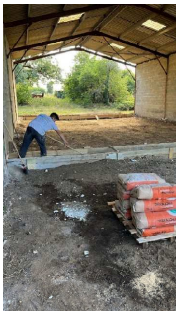
Début des travaux du bâtiment de l'atelier municipal
