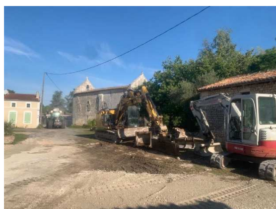
Village de St Paul : Travaux d'enfouissement du réseau par Enedis suite au sinistre de tempête sur le transformateur.
